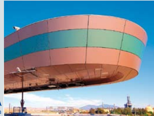
USA Toll Plaza
